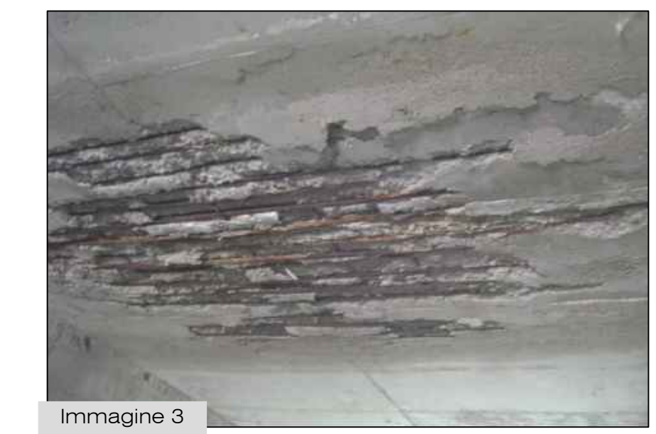
Immagine 3 Ammaloramenti del calcestruzzo con armature scoperte in prossimità del giunto, intradosso soletta
