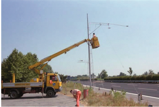
Foto 10 Sistema di array di microfoni utilizzati per la generazione della banca dati emissione dei veicoli
