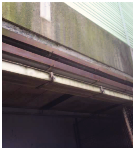
Fig.20 - Vista dei canali portacqua ancorati a bordo del viadotto Palmaro
