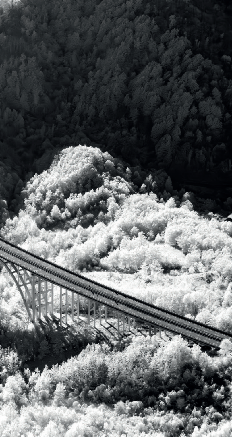
A1 Milano-Napoli / Viadotti Merizzano e Fosso Gambellato
