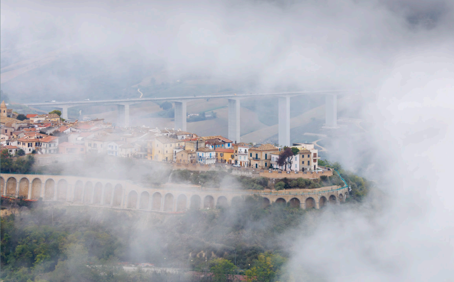
A14 Bologna-Taranto / Viadotto Cerrano
