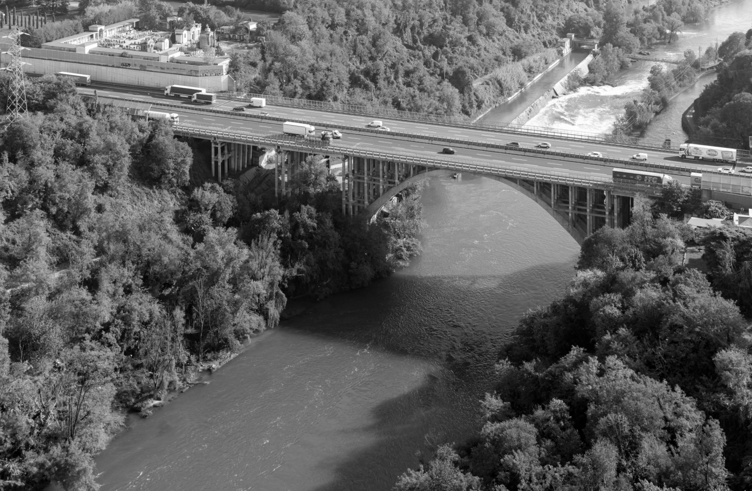
A4 Torino-Trieste / Ponte sul Fiume Adda
