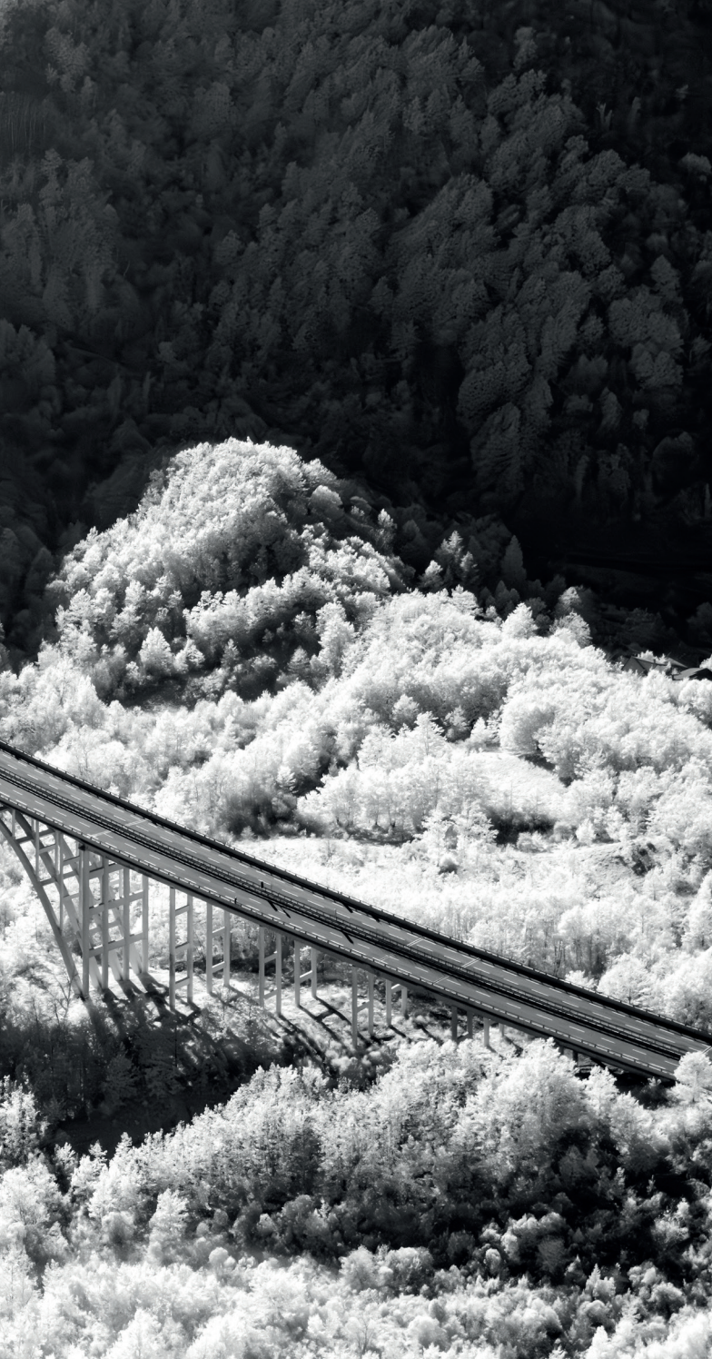
A1 Milano-Napoli / Viadotti Merizzano e Fosso Gambellato
