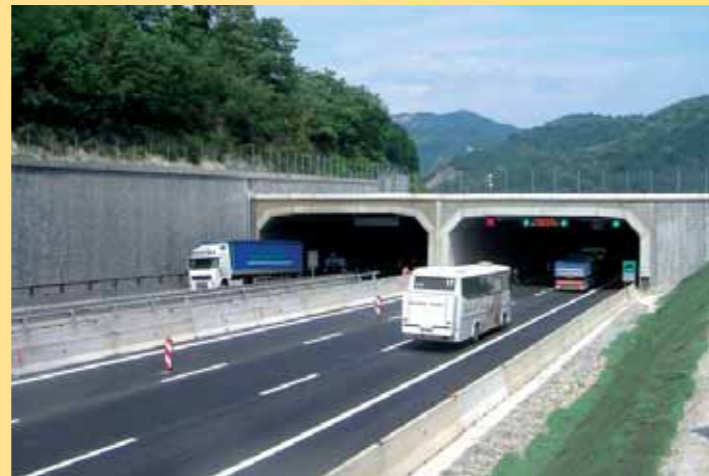
Imbocco Sud della Galleria Gardelletta
