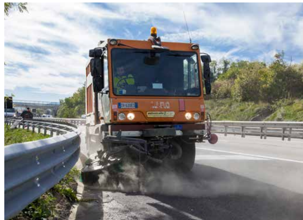
Nelle pagine precedenti e in queste pagine: operatori di Autostrade per l'Italia al lavoro per la manutenzione stradale e la segnaletica dei lavori in corso.
