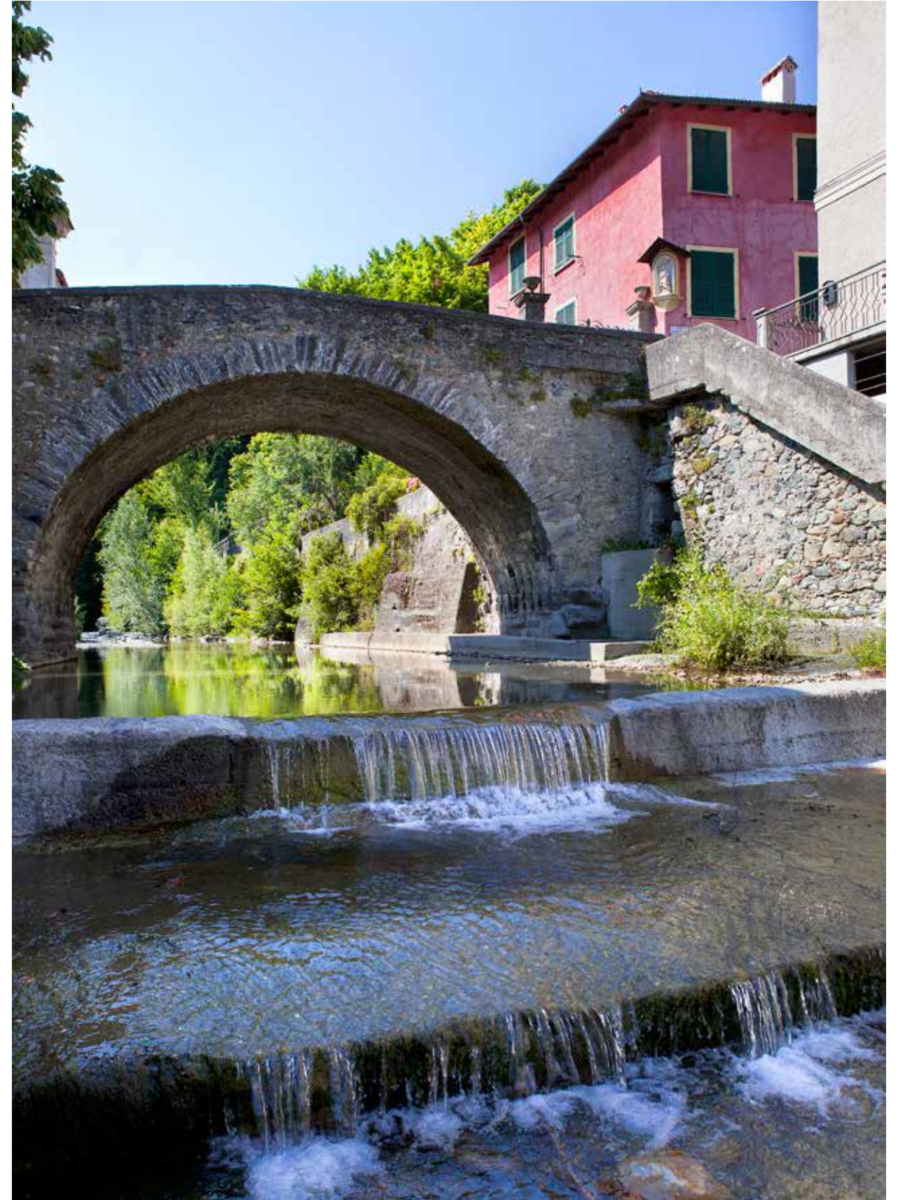
Voltaggio, ponte romano © F. Cicogna
