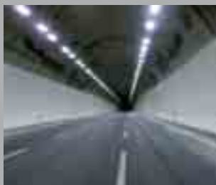
Ciclo di verniciatura a elevate prestazioni che consente il lavaggio del piedritto con basse pressioni
