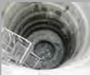
Consolidamento frana Viadotto Veilino A12 - pozzo drenante di grande diametro [€ 2.750.000]
