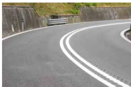
Nel corso del 2016 è stata avviata una nuova sperimentazione che prevede la realizzazione di Rumble Strips in parziale sovrapposizione alla striscia di margine destro.
