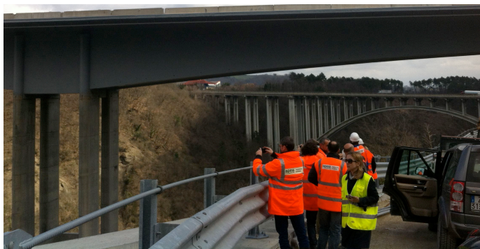
• Viadotto Aglio, vista dal basso
