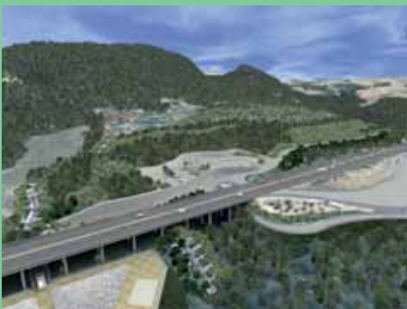
Il sito al completamento dei lavori e col ripristino ambientale
