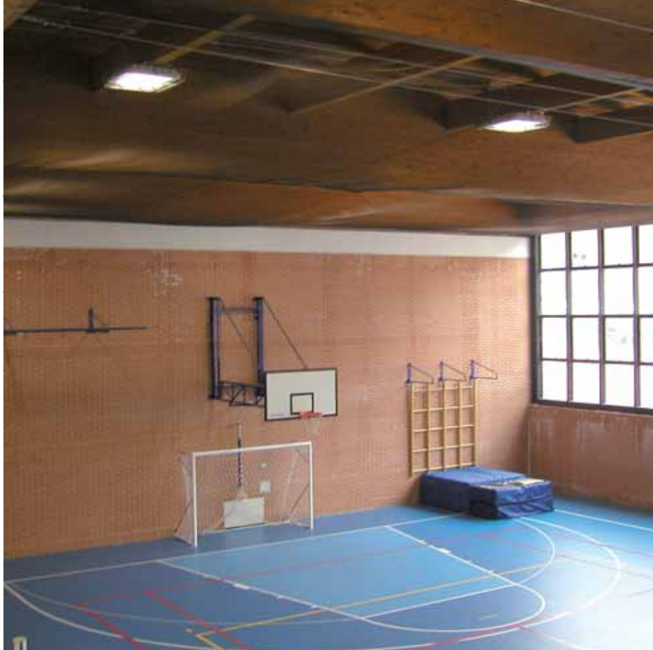
La palestra di Monzuno dopo i lavori di ristrutturazione
