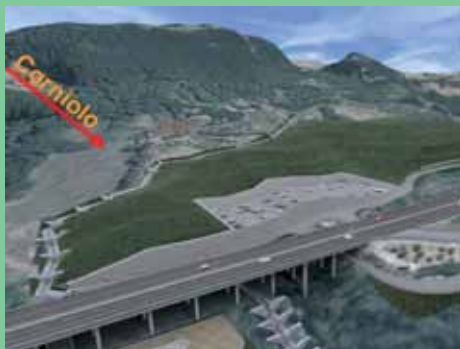
Il sito al completamento della costruzione con il riutilizzo dei materiali provenienti dagli scavi del nuovo tracciato
