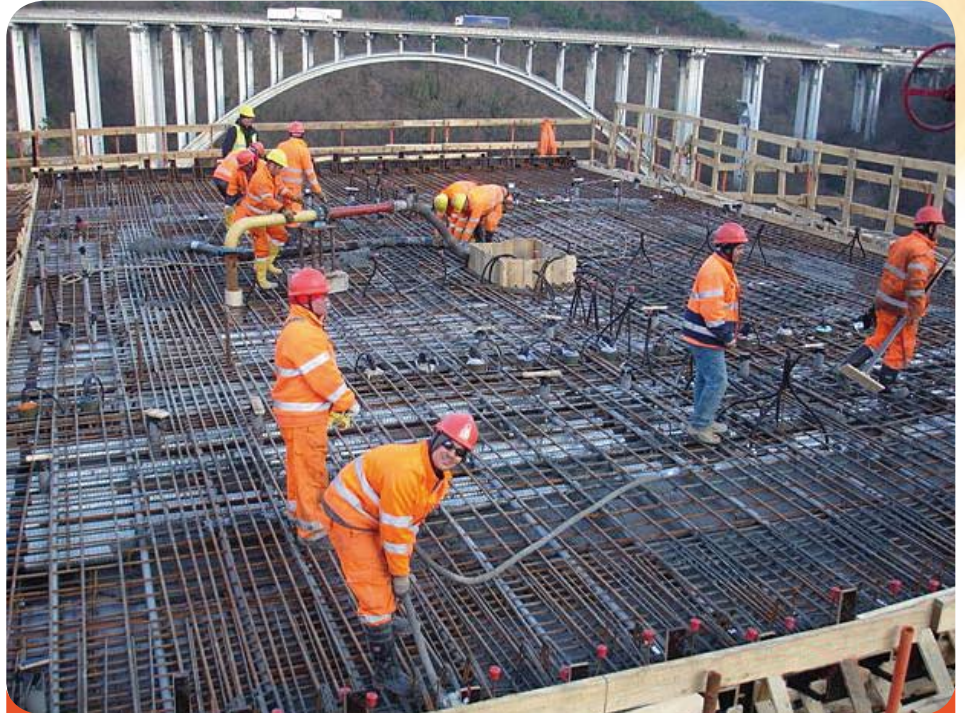
Operai al lavoro su una delle pile del Viadotto Aglio
