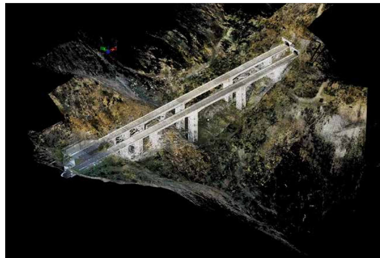
In queste pagine: alcune applicazioni del progetto Argo per il monitoraggio delle infrastrutture.
