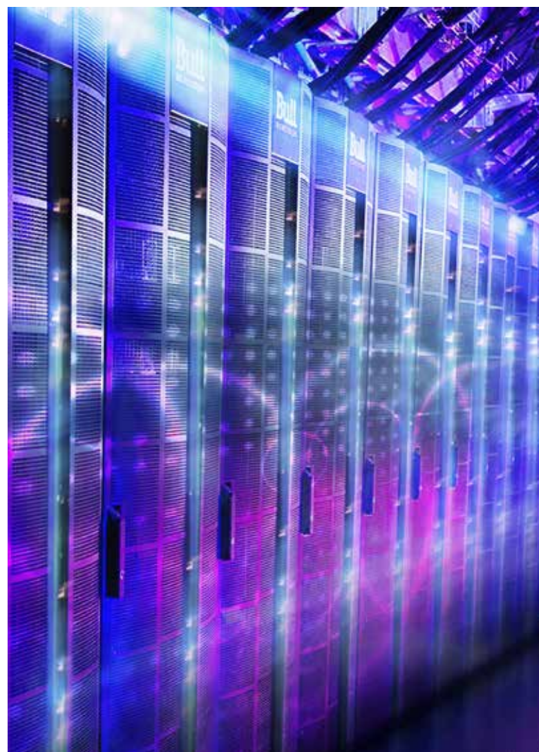
Nelle pagine precedenti e in queste pagine: il supercomputer davinci-1 di Genova.
