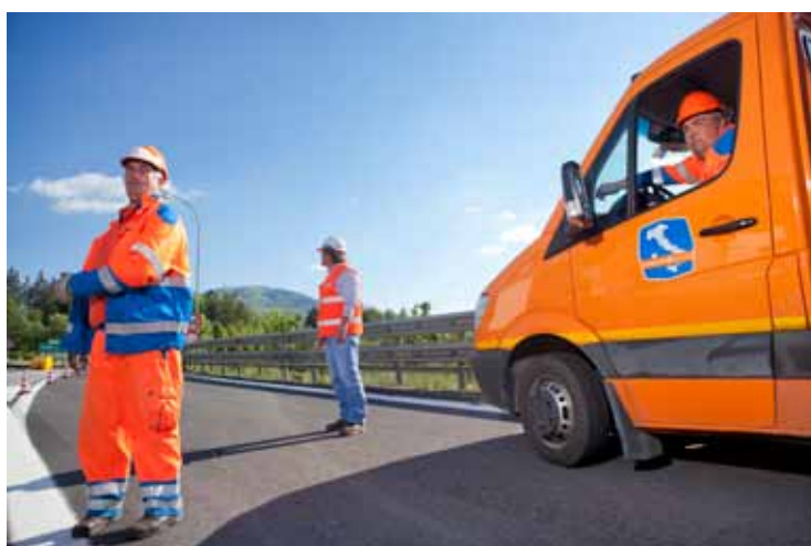
PIAN DEL VOGLIO La squadra di manutenzione del 4° Tronco gestisce il traffico e i lavori di un cantiere autostradale.
