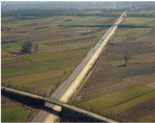
Autostrada Torino-Savona: lavori di raddoppio nel tratto Fossano-Mondovi
