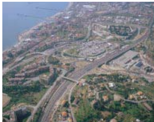
Il nuovo svincolo di Savona
